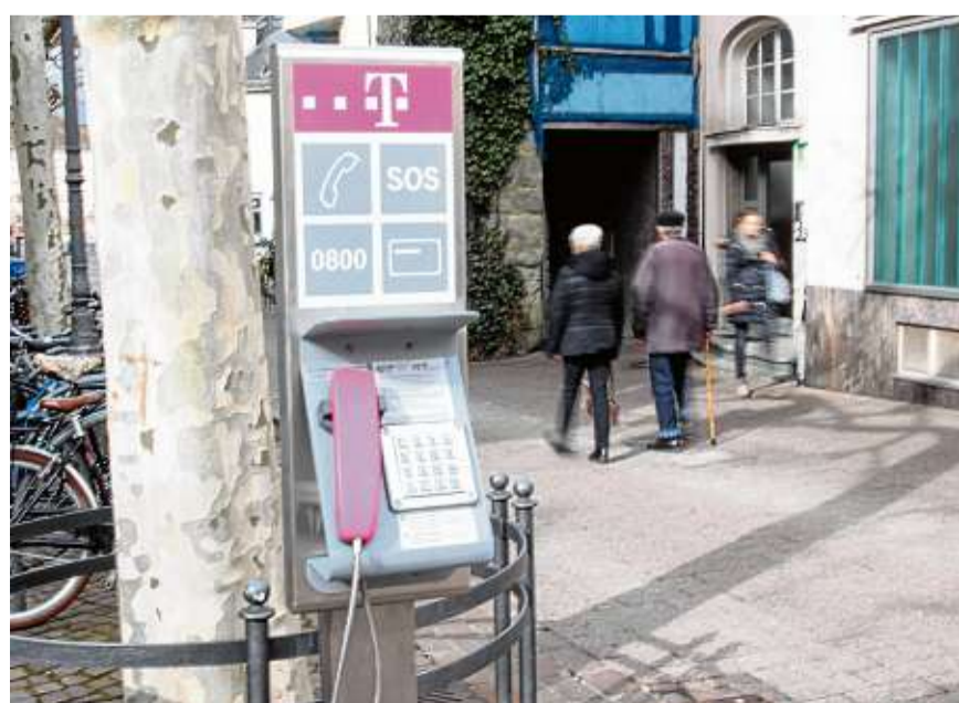
Schlanker, günstiger und mit weniger Funktionen: Telefonstelen, wie hier in der Schützenstraße, ersetzen oft ältere Telefonhäuschen. BILD: ROLF HOHL
